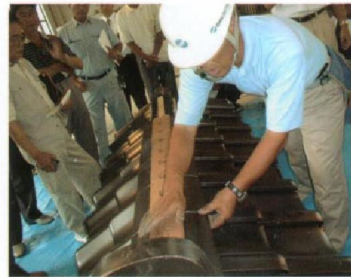
5. 鬼瓦仮付後、防災のし(大)取付
