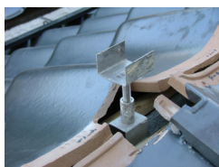
瓦を取り付けます
