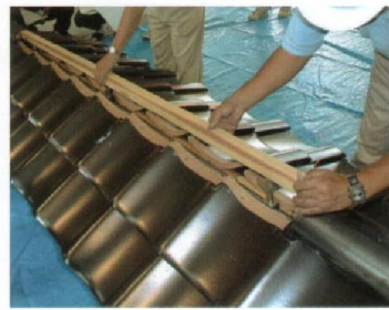
2. 受木取付 (棟金具高さ調整後)
