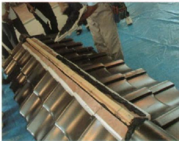
4. 馴染土施工後、防災のし(大)取付
